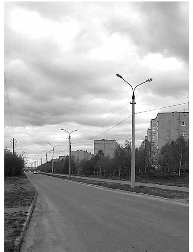
На улице Строителей и проспекте Сидоренко заменяют кронштейны, провода и светильники
